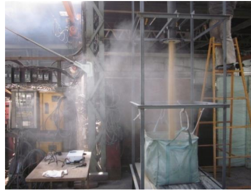
写真 1. 従来の短管シュート排出状況
