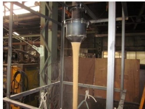
写真 2. 本ダストレスシュート排出状況
